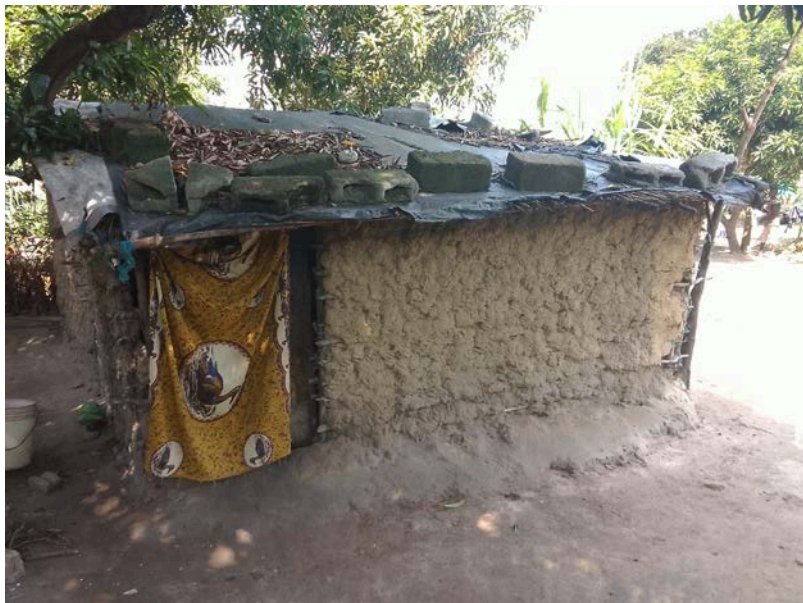
Habitação - Foto da esquina 2
