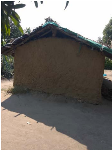
Habitação - Foto da esquina 2
