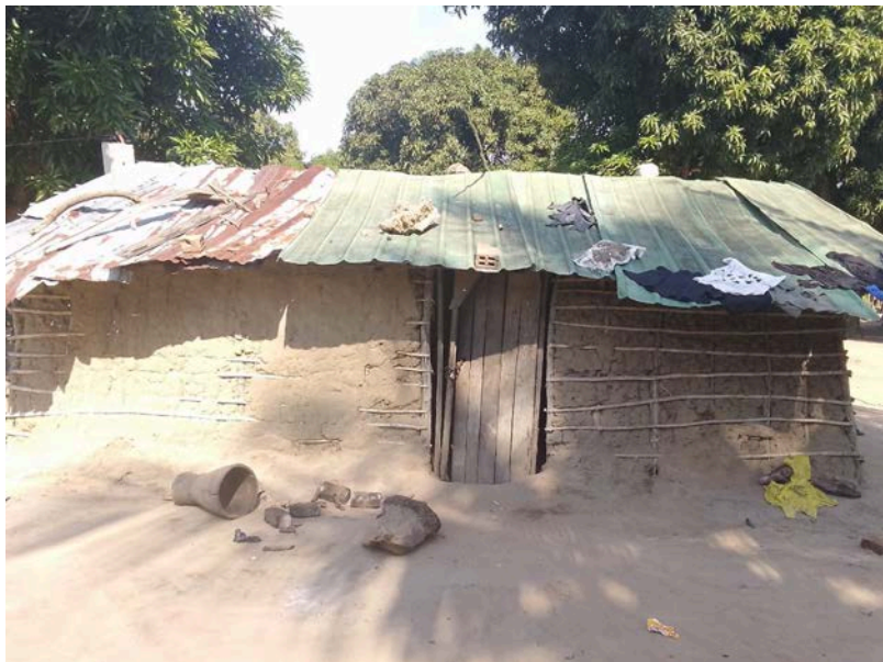
Habitação - Foto da esquina 2
