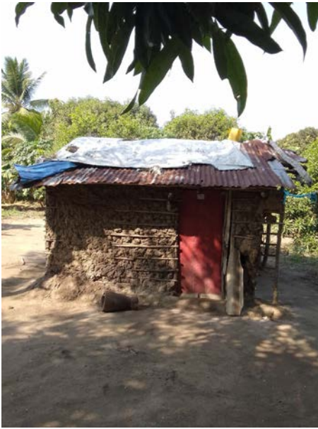
Habitação - Foto da esquina 2
