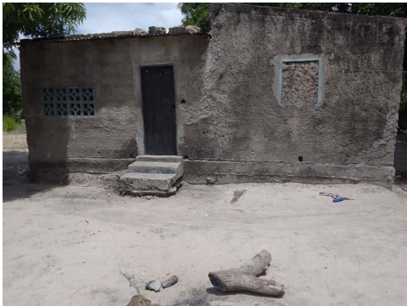
Habitação - Foto da esquina 2
