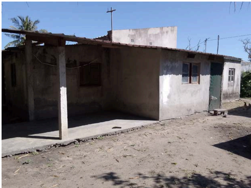
Habitação - Foto da esquina 2
