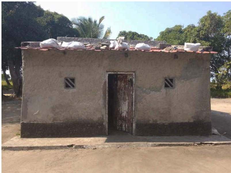
Habitação - Foto da esquina 2
