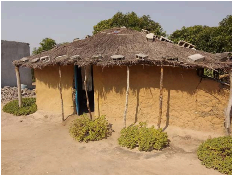
Habitação - Foto da esquina 2
