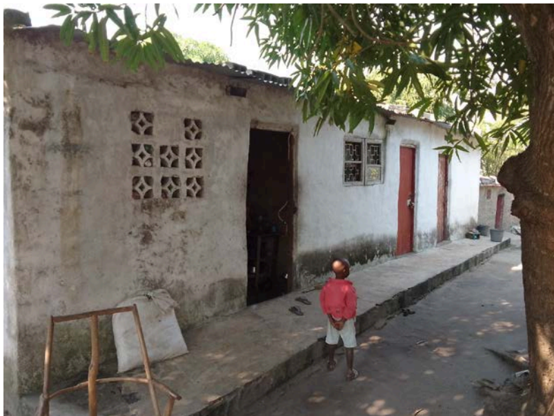
Habitação - Foto da esquina 2
