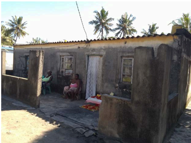
Habitação - Foto da esquina 2
