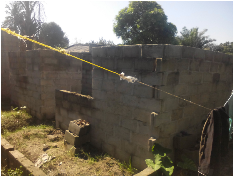
Habitação - Foto da esquina 2
