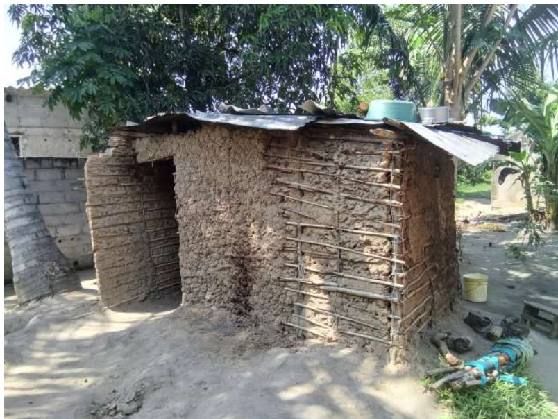
Habitação - Foto da esquina 2
