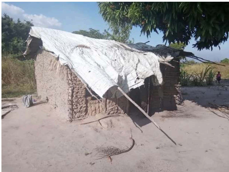
Habitação - Foto da esquina 2
