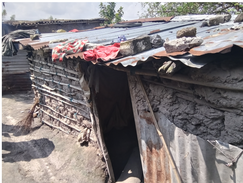
Habitação - Foto da esquina 2
