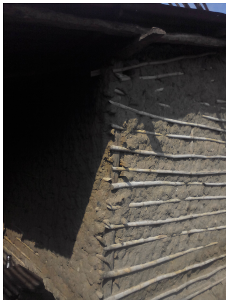
Habitação - Foto da esquina 2
