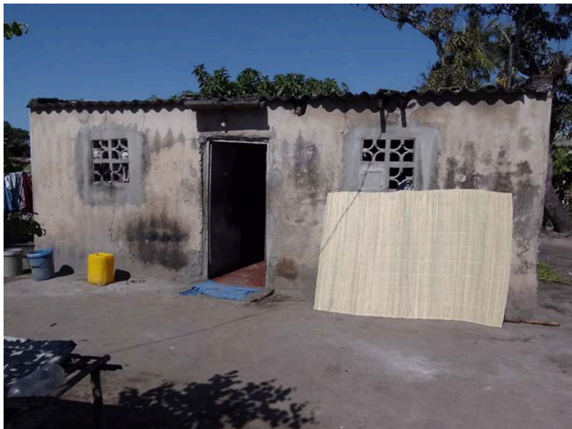
Habitação - Foto da esquina 2
