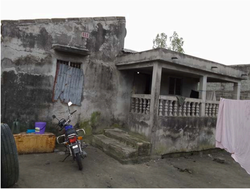
Habitação - Foto da esquina 2
