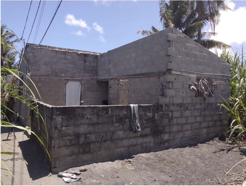
Habitação - Foto da esquina 2
