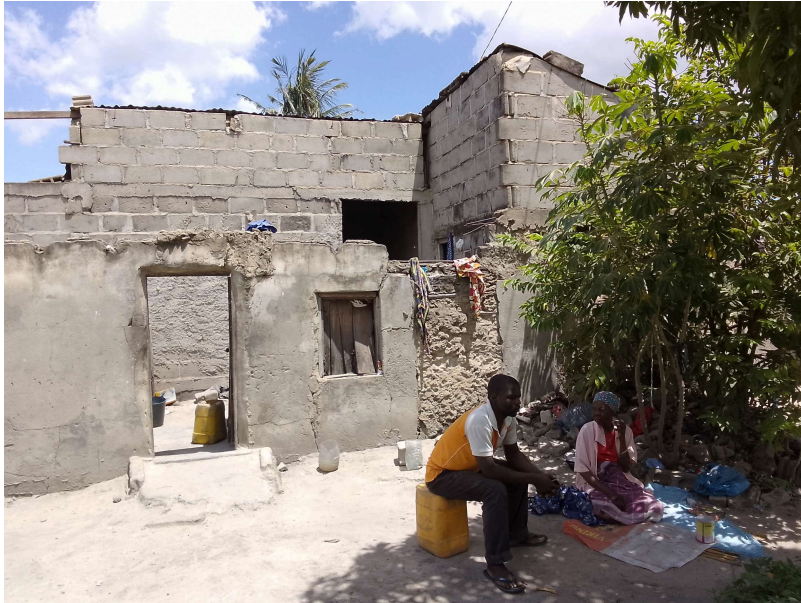
Habitação - Foto da esquina 2
