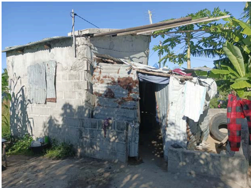
Habitação - Foto da esquina 2
