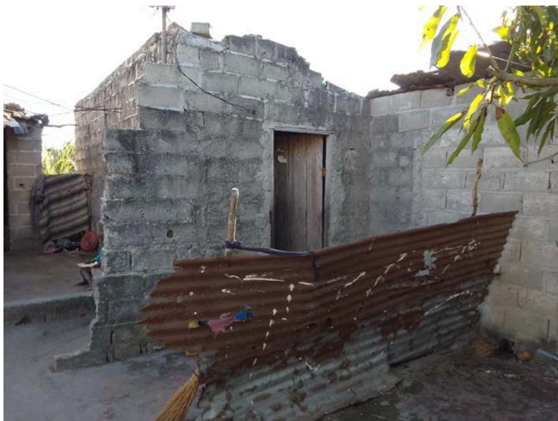
Habitação - Foto da esquina 2
