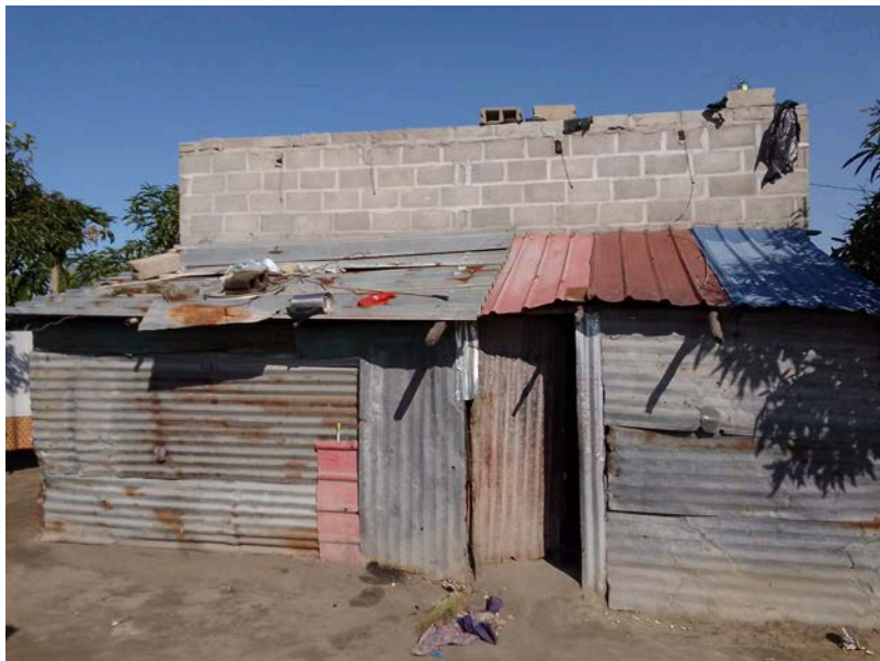
Habitação - Foto da esquina 2
