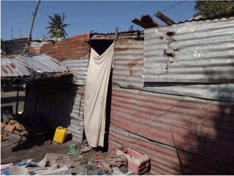
Habitação - Foto da esquina 2
