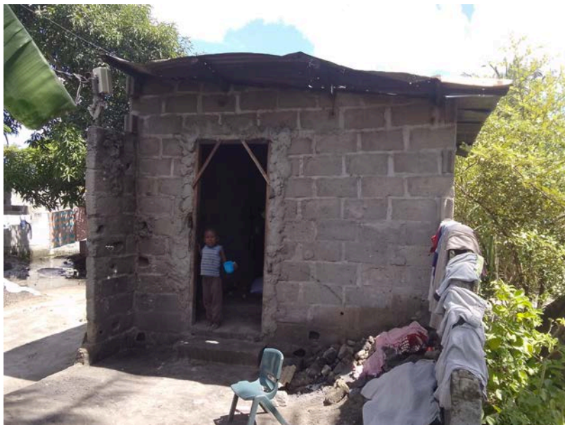
Habitação - Foto da esquina 2
