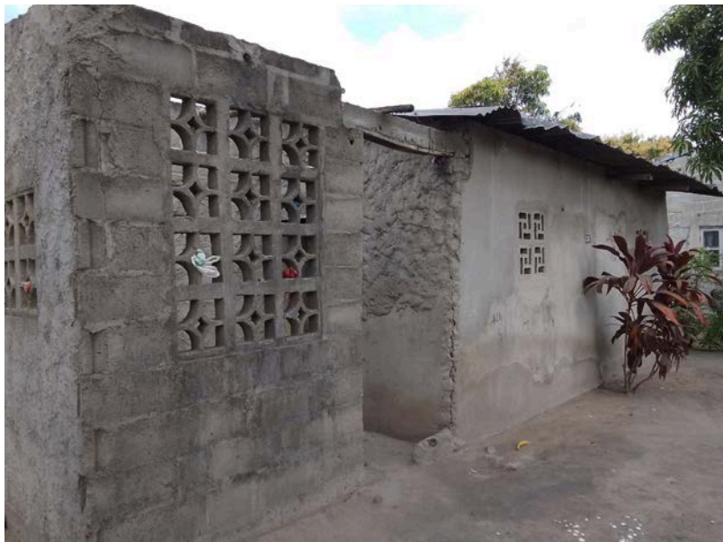
Habitação - Foto da esquina 2
