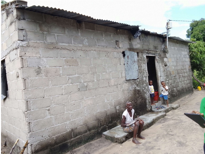
Habitação - Foto da esquina 2
