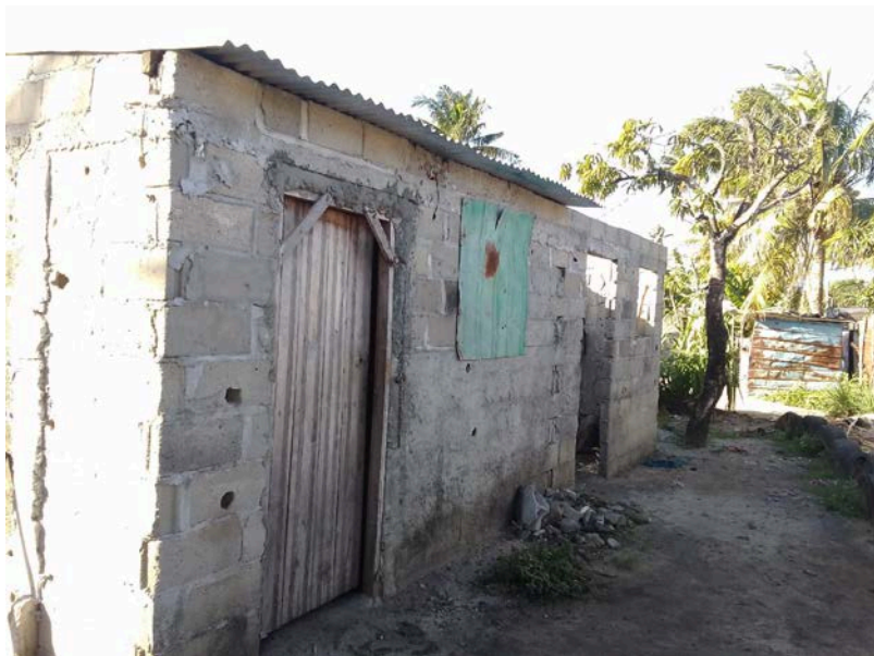
Habitação - Foto da esquina 2
