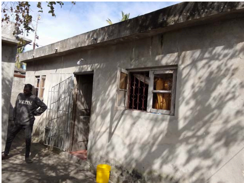
Habitação - Foto da esquina 2
