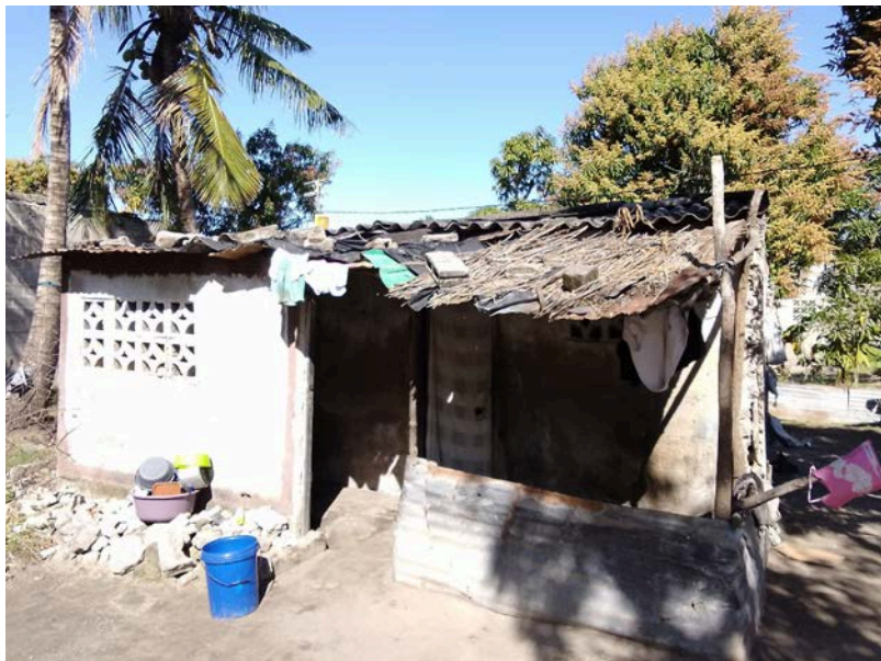
Habitação - Foto da esquina 2
