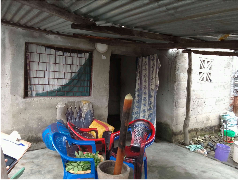
Habitação - Foto da esquina 2
