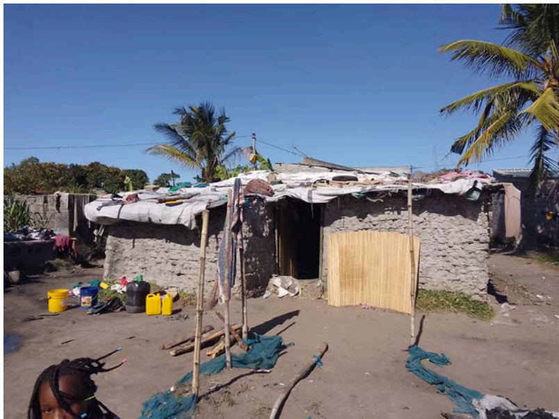
Habitação - Foto da esquina 2
