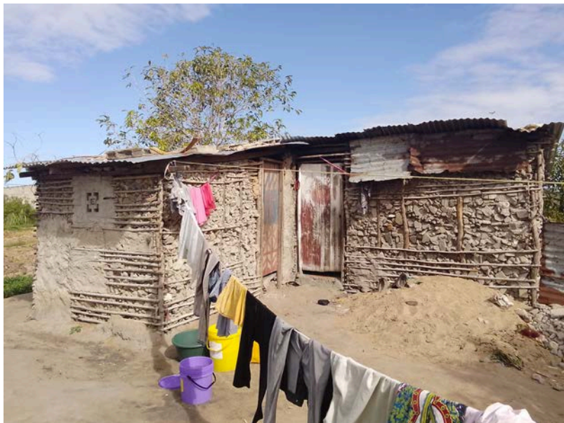
Habitação - Foto da esquina 2
