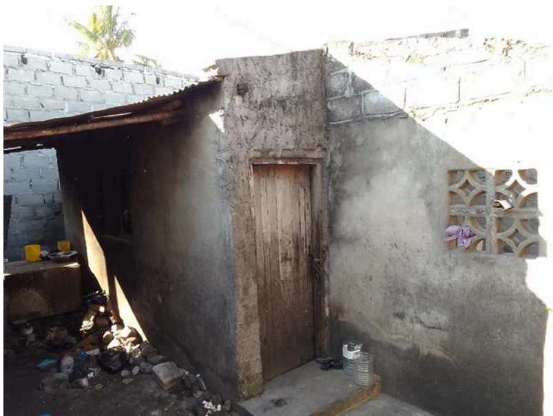
Habitação - Foto da esquina 2
