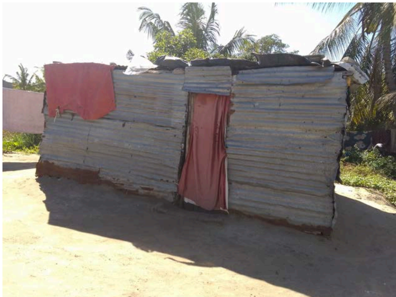
Habitação - Foto da esquina 2
