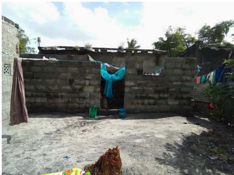
Habitação - Foto da esquina 2
