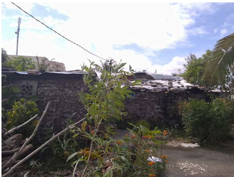
Habitação - Foto da esquina 2
